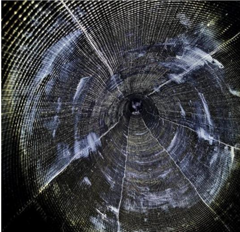
Hoop & Longitudinal layer installation
