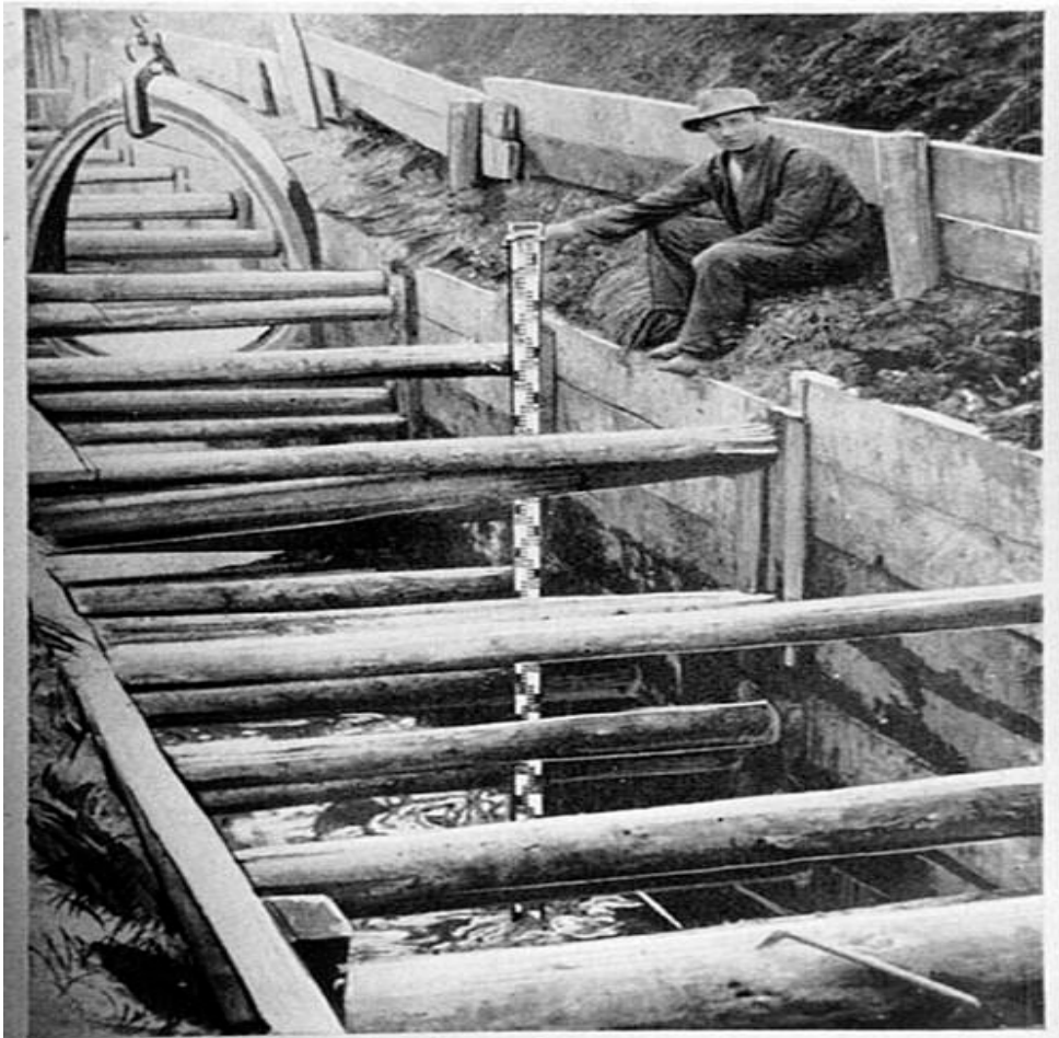
Abb 105. Das Bild veranschaulicht, mit welchen Schwierigkeiten der Einbau der Betonrohre in den moorigen Boden
