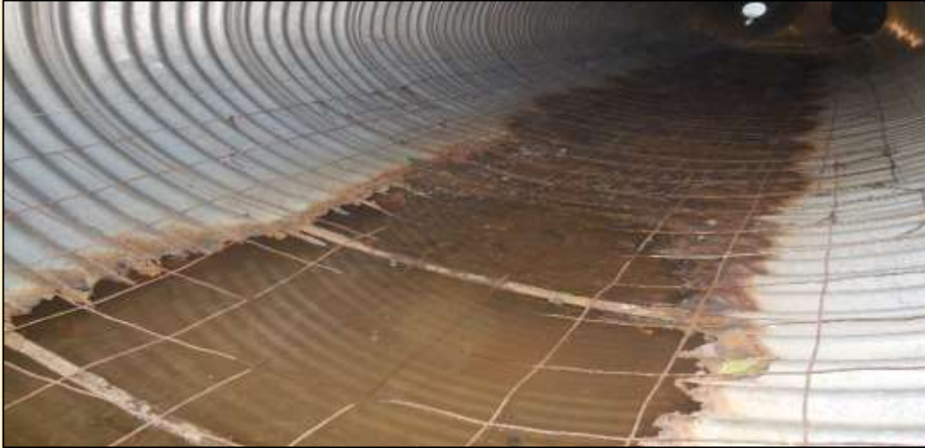
Cement Slurry Fills Voids
